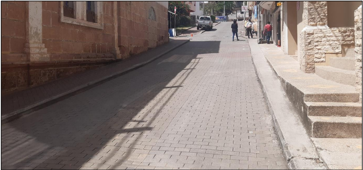
Imagen 37 Capa de rodadura de la red vial del Centro Urbano de Amaluza
