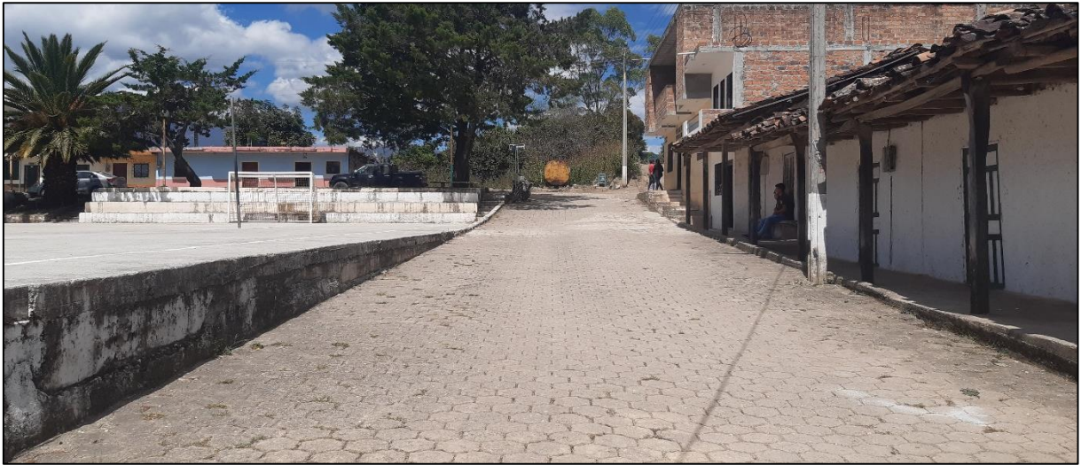
Imagen 38 Capa de rodadura de la red vial del Centro Urbano de Bellavista
