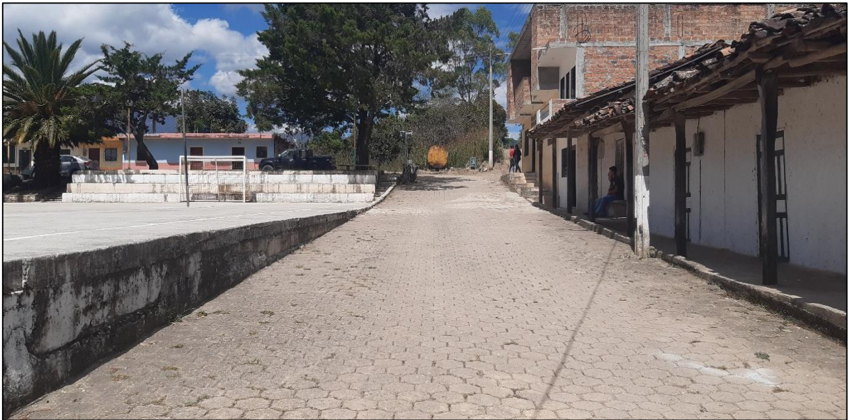
Imagen 37 Capa de rodadura de la red vial del Centro Urbano de Bellavista
